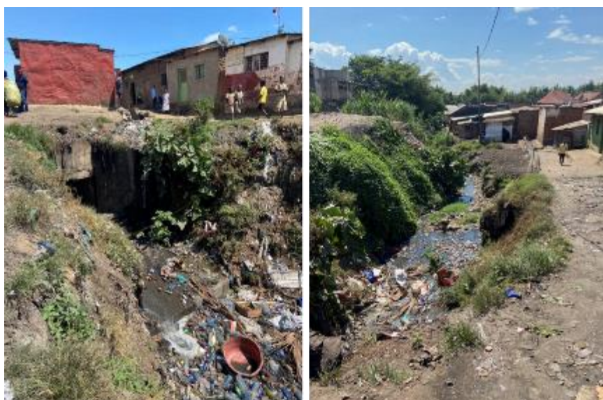
À gauche : un cours d'eau canalisé émerge de la zone principale du marché. À droite : le canal de drainage naturel et les débris associés
